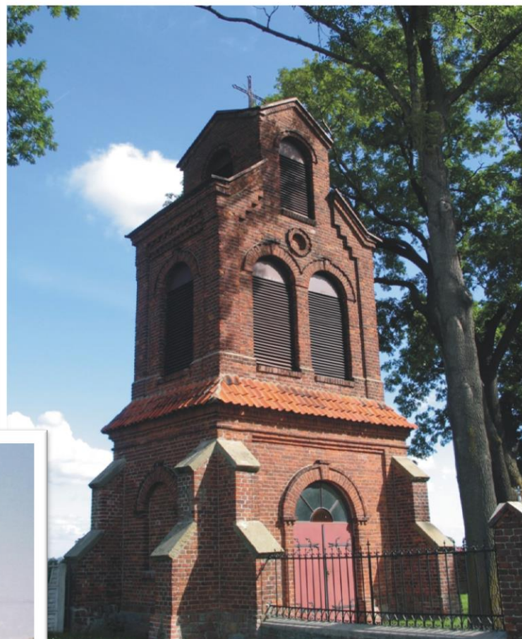
Dzwonnica zabytkowa, murowana, znajdująca się przy kościółce pw. Św. Marii Magdaleny w Grabkowie, powstała w końcu XIX wieku.
